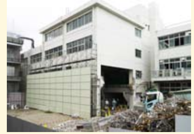
重機を入れるため、最初に新本館の2階部分を壊した。(2012年10月初旬)
